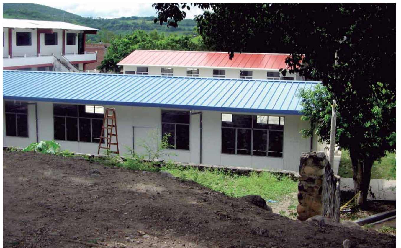
Módulos prefabricados en el distrito de Huarango - San Ignacio.
